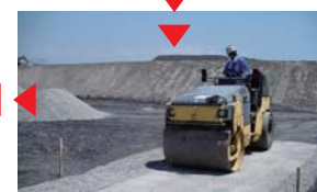
ベントナイト碎石転圧 Rolling compaction of crushed bentonite 碾压膨润土碎石
