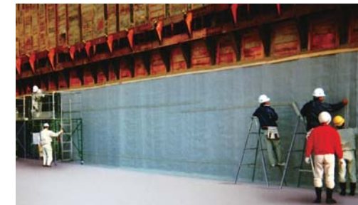
施工現場（和歌山県立美術館・博物館） Construction site (Wakayama Prefectural Museum and Museum of Art) 施工现场（和歌山县立美术馆、博物馆）
