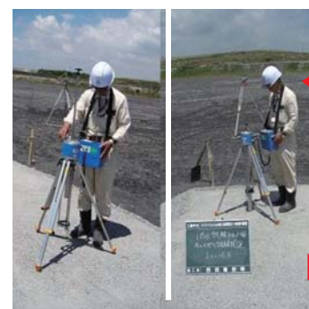
締め固め管理 (簡易支持力測定器カスフォル) Compaction control (Portable bearing tester CASPFOL) 压实管理 (简易支撑力测量仪 CASPFOL)
