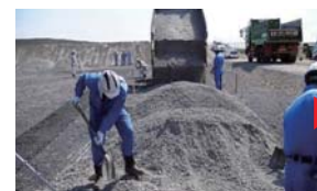
ベントナイト碎石搬入 Application of crushed bentonite 搬入膨润土碎石
