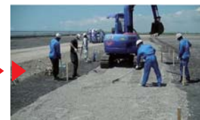
ベントナイト碎石敷均し Spreading of crushed bentonite 铺匀膨润土碎石
