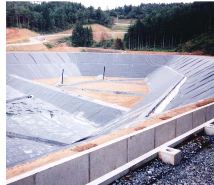
ガンドシールを使用した最終処分場 A landfill site using GUNDSEAL 使用了 GUNDSEAL 的最终处理场
