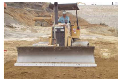
ベントナイト混合土敷設中
