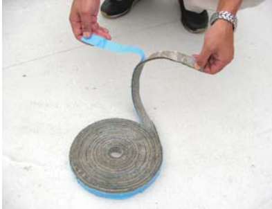
① 打継面の汚れ、木屑、異物等を取り除く。 作業工程に合わせて剥離紙をはがす。
