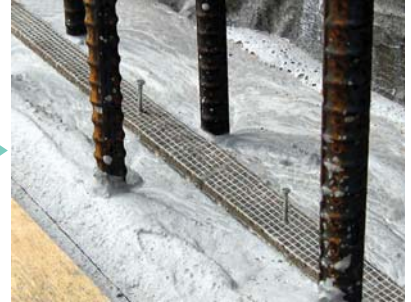
③ ジョイント部は切り口部をあわせて 釘打ちにて固定。
