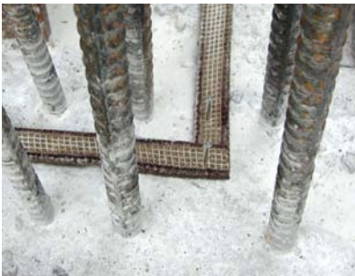
④ 隅部、コーナー部は切断して調整。 ジョイント部は切り口部をあわせて固定。
