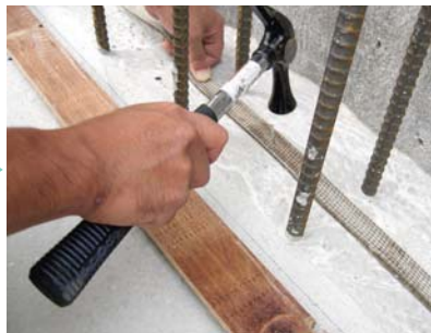
⑤ 300～600mmピッチで釘打ち固定。
