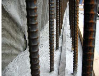
② 剥離紙を施工面に設置。
